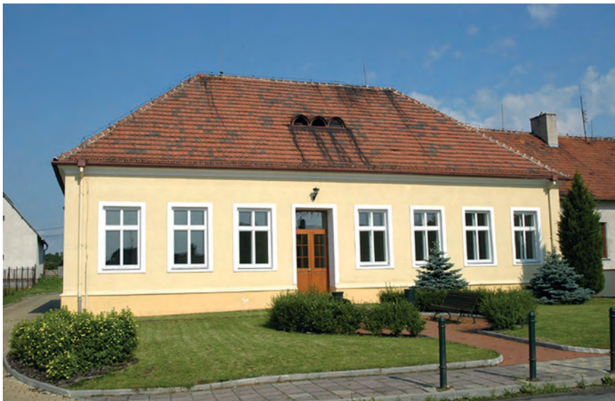
Bývalá vlčkovská škola slouží kultuře, náboženství i sportu.
