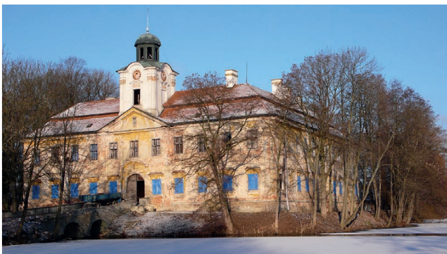
Současný pohled na zámek připravený k rekonstrukci.
